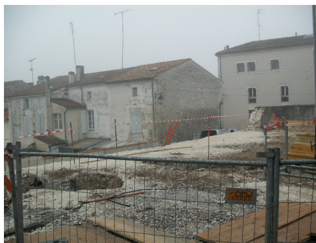
L'emplacement de la dernière partie
