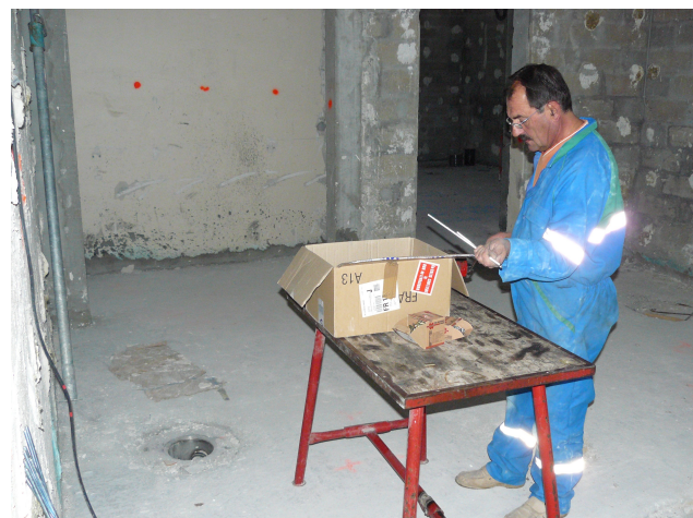
Les plombiers préparent la pose de ses tuyaux
