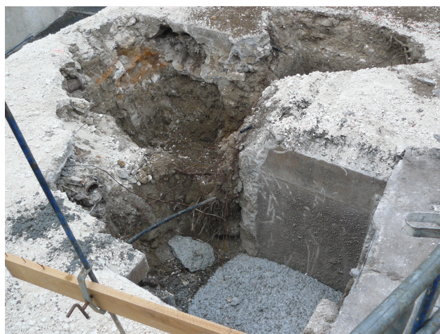
Un gros trou pour préparer les fondations
